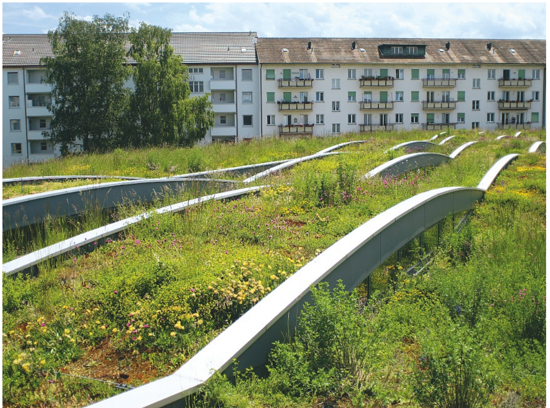
Sehr gutes Beispiel eines strukturreich begrüntes Daches (Tramdepot Wiesenplatz). © S. Brenneisen
