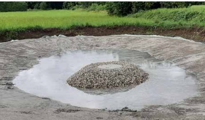
Nachdem der Oberboden abgegraben war wurden die Vertiefungen mit Folie und Beton ausgekleidet, damit kein Wasser aus den Weihern und Tümpeln ins Grundwasser gelangen kann. Der Betonschacht in der Bildmitte dient als Grundablass, um den Weiher bei Bedarf ablassen zu können.
