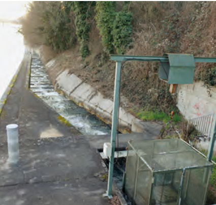
Fischtreppe beim Kraftwerk Birsfelden (mit Kontrollreuse). Wegen der ungenügenden Lockströmung finden nur wenige Fische den Weg ins Oberwasser.
